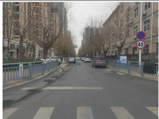
本项目东侧现状照片
