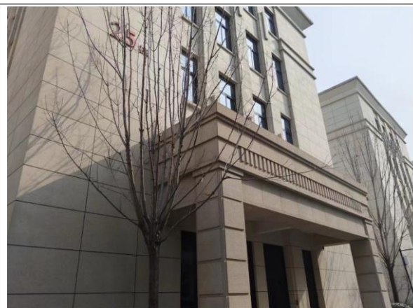
项目东侧联东U谷25号楼（空置）
